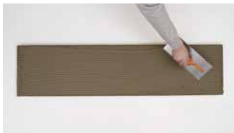
Nanášení BIOGEL ® NO LIMITS ®
