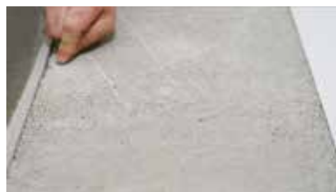
CEMENTOVÝ POTĚR ověření tvrdosti a čistoty
